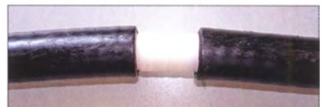
Bild 10: Nachdem der Schirm entfernt wurde, sollte die Trennstelle etwa so aussehen.
