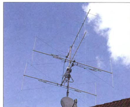
Antennenanlage auf dem Hausdach bei DL3VL; oben 2-m-, darunter 70-cm-Kreuzyagi-Antenne; unten Butternut HF5B für KW Foto und Scan: DL3VL
