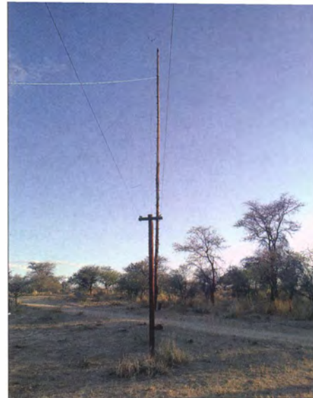
Die Rhombus-Antenne mit 600-Ω-Zweidraht-Zuleitung
