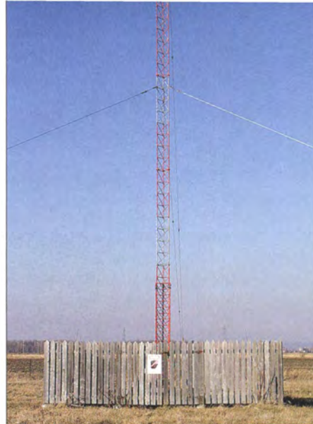
Bild 3: CHU sendet auf seinen drei Frequenzen über Vertikalantennen, die jeweils mit einem umfangreichen Netz von Radialen verbunden sind.
